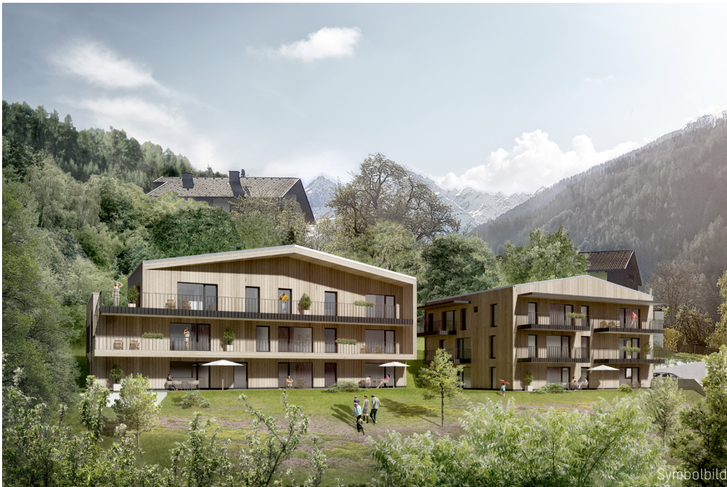
Wohnanlage Greitweg, Kauns 17 Mietwohnungen
