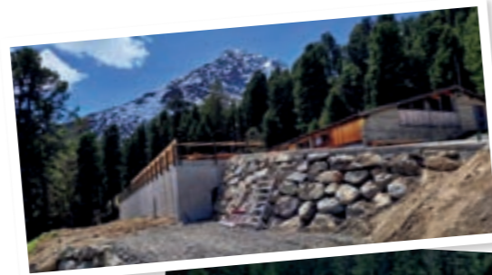
◀ Güllegrube auf der Nassereinalm
